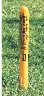
Los marcadores de alta visibilidad con el número de teléfono para emergencia las 24 horas de CPS Energy indican que hay que prestar mayor atención cerca de todos los gasoductos de alta presión y algunas tuberías de distribución.
